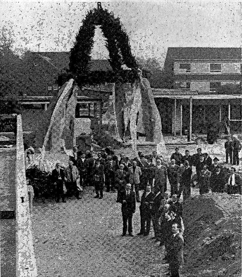
eubau des Freibades in Sythen.
