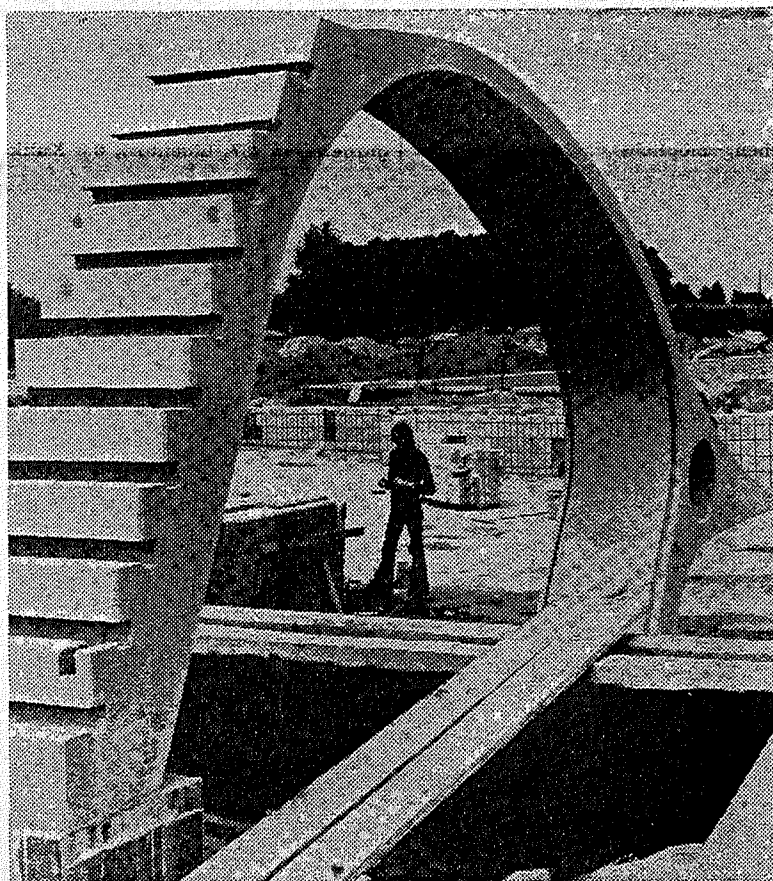
Fertig betoniert ist die Rutschbahn am Nichtschwimmerbecken des neuen Freibades in Sythen. Ab Mai nächsten Jahres können sich hier die Kinder im kühlen Naß austoben. RN-Foto: Lücke
